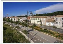
Une maison individuelle > 300 tonnes
