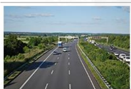
Un kilomètre d'autoroute > 30 000 tonnes
