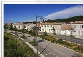
Une maison individuelle > 300 tonnes
