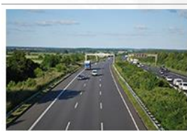
Un kilomètre d'autoroute > 30 000 tonnes
